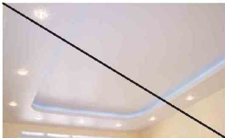
Плохо Многоуровневые гипсокартонные конструкции
