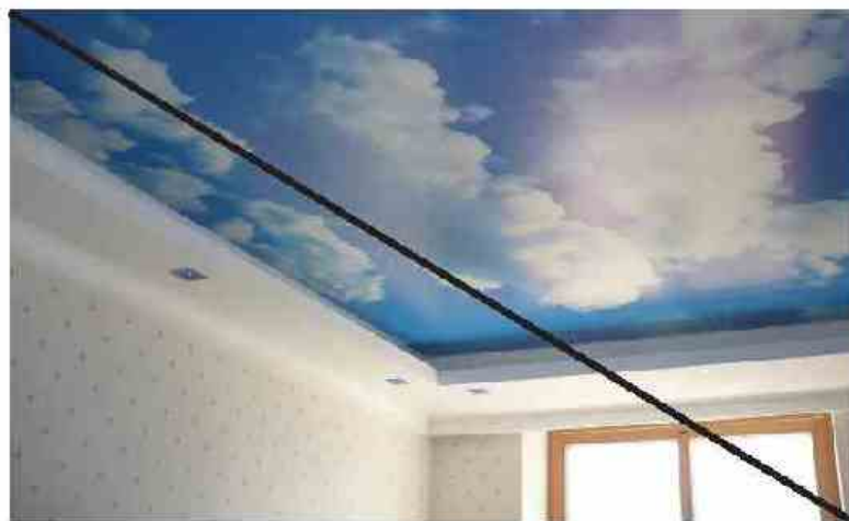
Плохо Натяжные потолки. Потолки с рисунками
