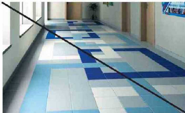
Плохо Цветные вставки из плитки
