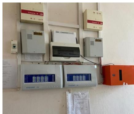
Система оборудована дымовыми извещателями. Установлена кнопка экстренного вызова сотрудников полиции. Имеется круглосуточное видеонаблюдение. Система видеонаблюдения включает в себя 4 наружные видеокамеры. Установлен домофон, имеется стационарный и ручной металлоискатель.
